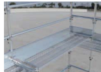
施工イメージ
